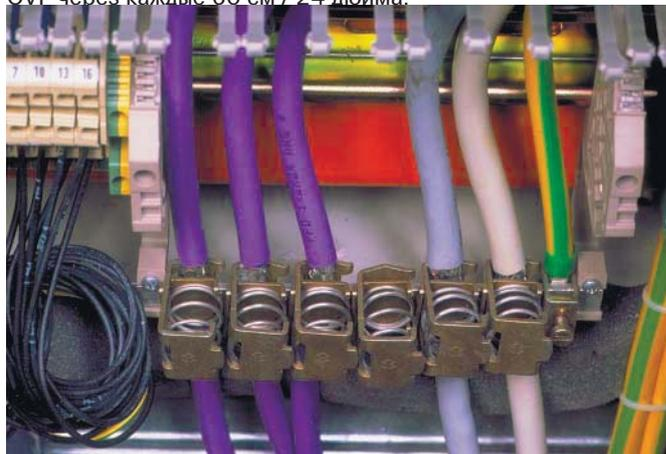
Экранированные сигнальные линии должны подсоединяться к проводнику PE через клеммы с бугельным зажимом (Weidmüller KLBÜ). Неэкранированные линии должны быть скручены. Предпочтительно заземление в форме звезды (заземление нейтрали). Все модули защиты, относящиеся к одной части установки, должны иметь заземление нейтрали. Следует не допускать сквозное соединение заземления. Защищенные и незащищенные линии должны быть проложены отдельно.
