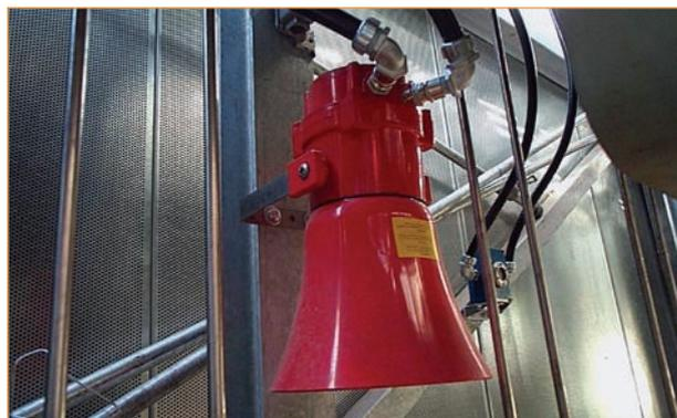
Звуковое оповещение на газовой электростанции: звуковой оповещатель BExS 120 ATEX
