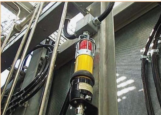
Световой оповещатель для газотурбинного генератора: проблесковая лампа CWB-ATEX
