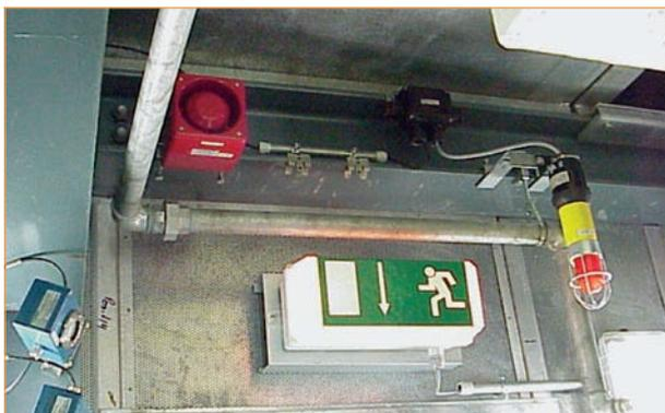
Распознавание газа со световой и звуковой сигнализацией: звуковой оповещатель DS 10 ATEX
