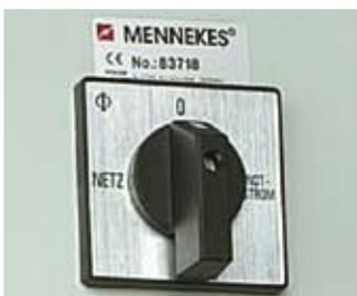
**Переключатель** (сеть/выкл./резерв) механический (на ток 63А) присутствует в изделиях на токи 16А и 32А.
