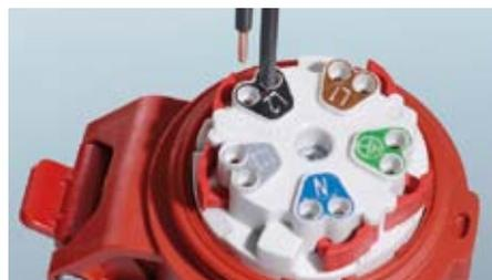
Подходит для одно- и многопроволочных жил (в последнем случае - с кабельными наконечниками или обработанные ультразвуковой сваркой).
