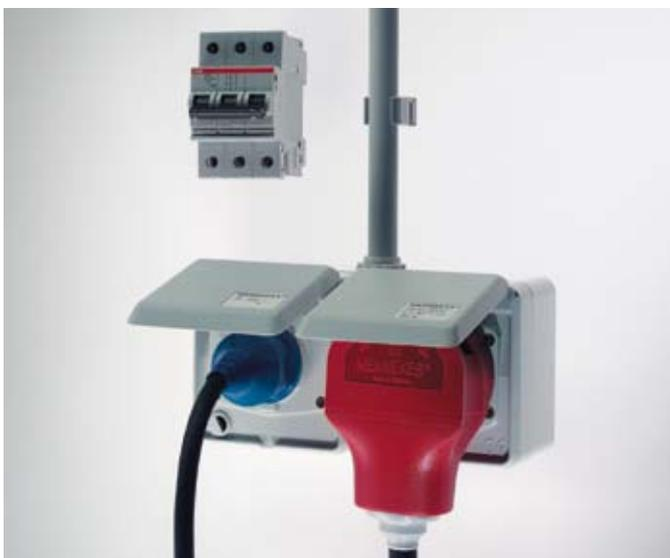
Широко распространенная комбинация: розетки CEE, 16А и розетки SCHUKO®, 16А. При подключении данной пары к одному кабелю обязательно подключение 3-полюсного автомата.
