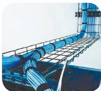
► КАБЕЛЬНАЯ ТРАССА, ПРОЛОЖЕННАЯ В ЛОТКЕ CABLOFIL ШИРИНОЙ 300 MM
