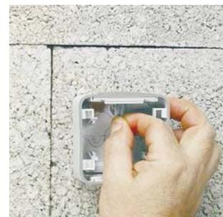
Вручную удалите центральную часть мембраны на торцевой заглушке, потянув за язычок
