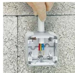
Мембрана торцевой заглушки компенсирует любое отклонение трубки от вертикали и обеспечивает степень защиты IP55
