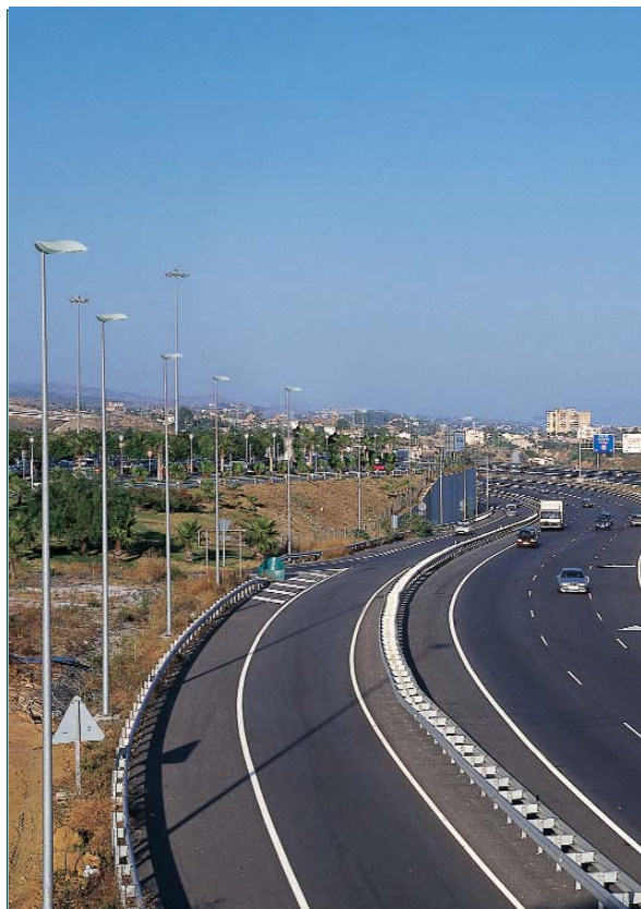
Подъездные дороги к городам
