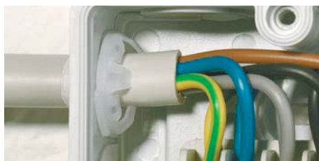
Фиксация кабеля с помощью фиксаторов КНР
