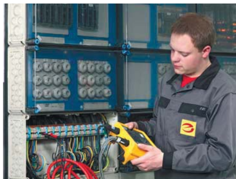
Электрические распределительные щиты до 630 А для установки электрических устройств (PSC) в соответствии со стандартом DIN EN 61 439 Часть 2
