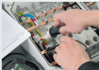
Монтажные распределительные шкафы до 250 А испытываются при напряжении от 500 В пост. тока. Для остальных распределителей свыше 250 А проводится высоковольтное испытание.
