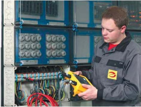
Электрические распределительные щиты до 630 А для установки электрических устройств (PSC) в соответствии со стандартом DIN EN 61 439 Часть 2
