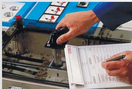
Необходимо проконтролировать функциональность элементов защиты механического действия, напр. приводов выключателей, запоров крышек и дверок.
