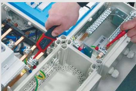
Необходимо провести проверку изоляции цепи защитного проводника.
