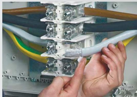
1. Оголенный конец провода должен быть тщательно очищен, например ножом, от оксидного слоя. При этом не должны использоваться напильники, наждачная бумага или щетки.
