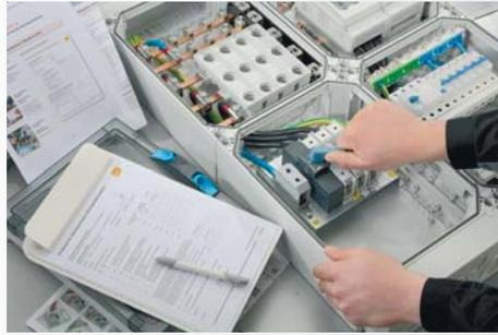
Необходимо проконтролировать функциональность элементов защиты механического действия, напр. выключателей, запоров пластроны и дверцы.
