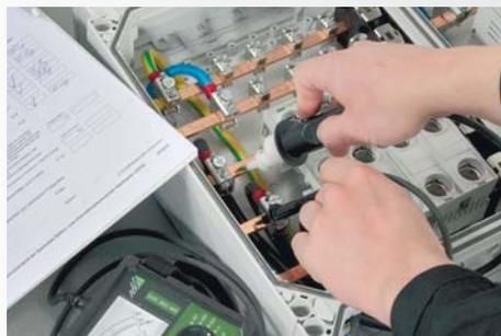
Для распределительных устройств до 250А выполняется контрольный замер напряжения 500 V DC.
