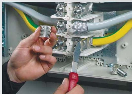
3. Так как алюминий склонен к текучести, необходимо подтянуть клеммы **перед вводом в эксплуатацию и после первых 200 часов работы** (учитывая крутящий момент затягивания).
