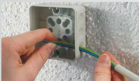
■ Ввод кабеля без инструментов через эластичные уплотнительные мембраны... Просто проткнуть проводом – и готово!
