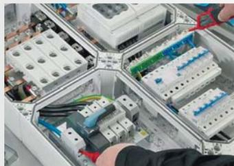
Провода должны быть проверены на соответствие с принципиальной схемой, а также выборочно проверены резьбовые соединения.
