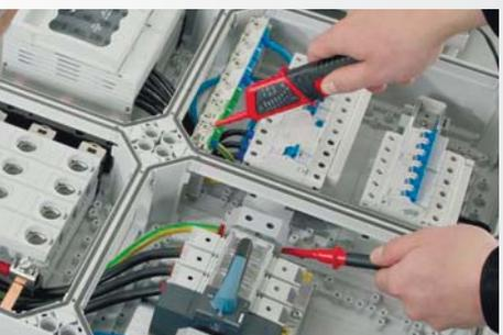
Цепи защитного провода должны проверяться на пробой изоляции.
