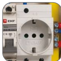
Имеется узел подключения строительного инструмента
