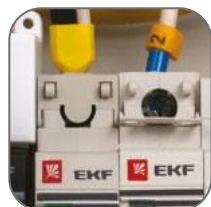
Имеет пломбировку вводного аппарата
