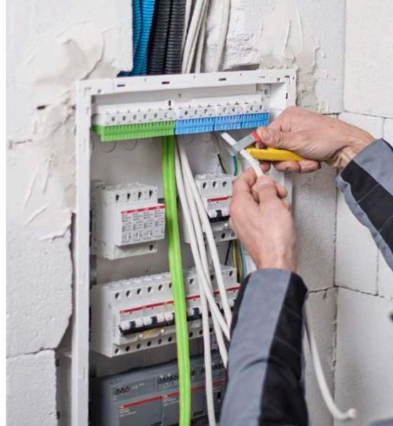
Пространство для подключения кабелей было увеличено на 200% по сравнению с предыдущим поколением щитов UK500. Съёмный фланец с разметкой для ввода проводников и «гребёнка» для их фиксации значительно упрощают процесс подключения щита к сети и нагрузкам. Щиты можно устанавливать во все типы стен: как в сплошные, так и в полые (с помощью многоразового набора UZ91P4).
