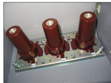
Конусы типа С Выключатель нагрузки 630А без трансформаторов тока
