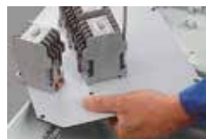
Монтаж устройств на монтажную плату
