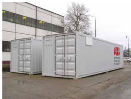
Рис. 1. Контейнер с распределительным устройством
