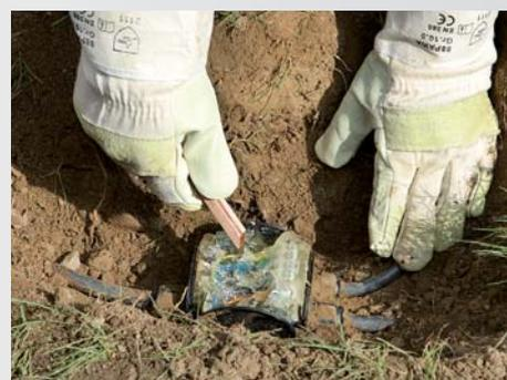
Таким образом, проникновение жидкости и образование конденсата исключено полностью. Герметизирующий компаунд может быть легко удален для проведения ремонтно-восстановительных работ, или новых подключений.
