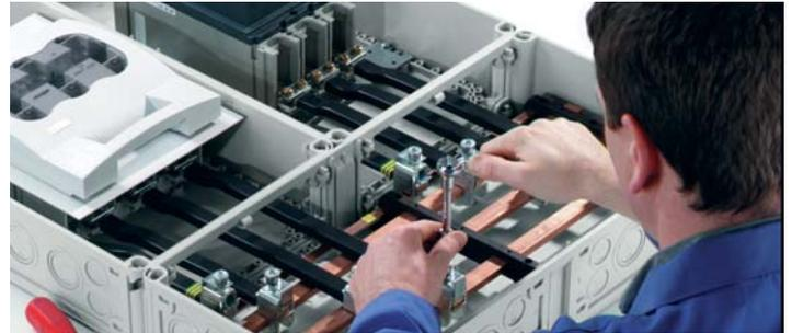
Проводники должны быть проверены на правильность соединения с однолинейной схемой, в произвольном порядке проверить болтовые соединения.
